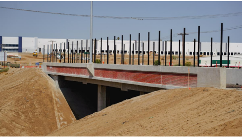
Trabajo de cercas en los puentes.
