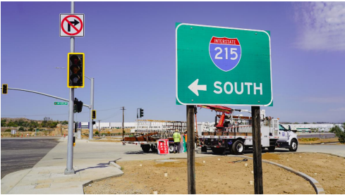
Equipos instalando nuevos letreros.
