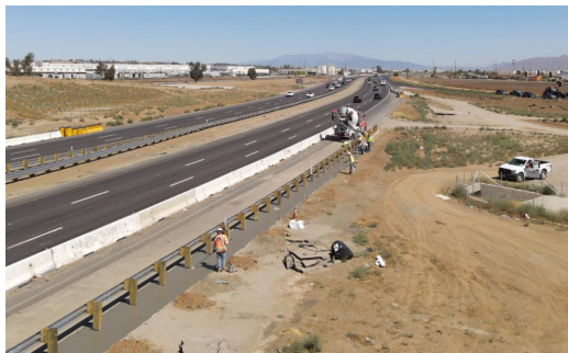
Cuadrillas pavimentan alrededor de la nueva barandal la I-215 por abajo del puente Placentia Ave.
