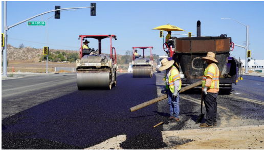
Las cuadrillas pavimentan Placentia Ave.
