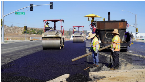
Las cuadrillas pavimentan Placentia Ave.
