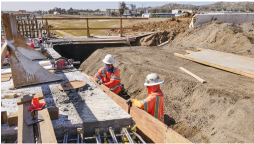
Cuadrillas trabajan en el puente de Placentia Ave. sobre la I-215.
