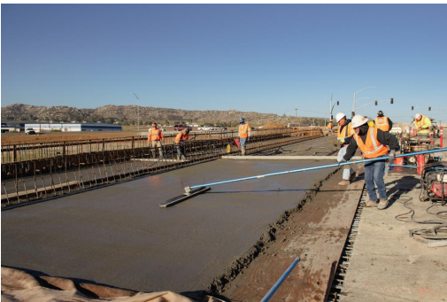
Trabajo de concreto en el puente de Placentia Ave. sobre la I-215.
