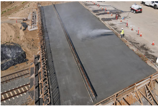
Cuadrillas trabajan en el puente de Placentia Ave. sobre las vías de ferrocarril.
