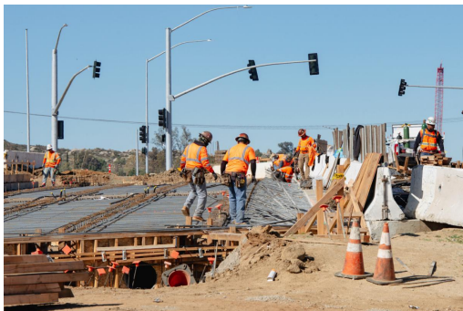
Cuadrillas trabajan sobre el puente en Placentia Ave. sobre las vías de ferrocarril.
