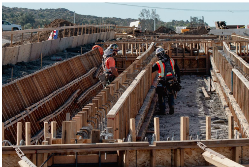
Las cuadrillas trabajan en la parte interior del puente de Placentia Ave.
