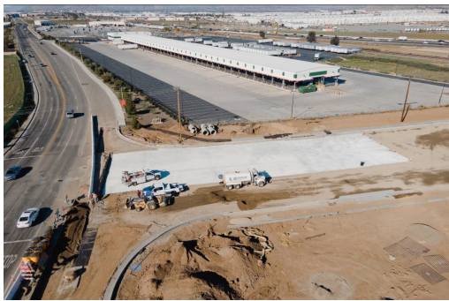
La base de concreto se vertió en Placentia Ave. cerca de Harvill Ave.
