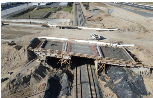
El puente en Placentia Ave. sobre las vías de ferrocarril.
