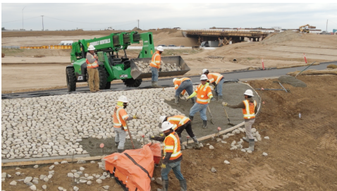
Las mantas de roca decorativa se están instalado.
