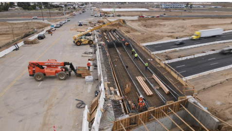
Las cuadrillas ponen varillas para la expansión del puente de Placentia Ave.
