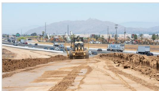
Equipos de construcción continúan nivelando la nueva salida hacia el sur.
