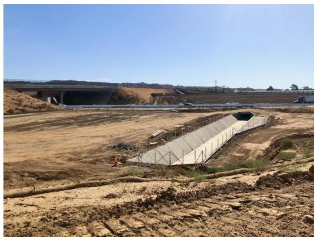
Cuadrillas recién completaron trabajo de concreto para un sistema nuevo de drenaje.
