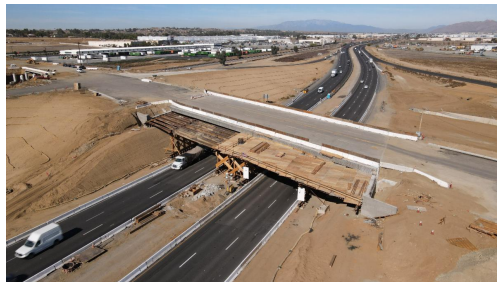
El progreso de la estructura de soporte para la expansión del puente arriba de la I-215.
