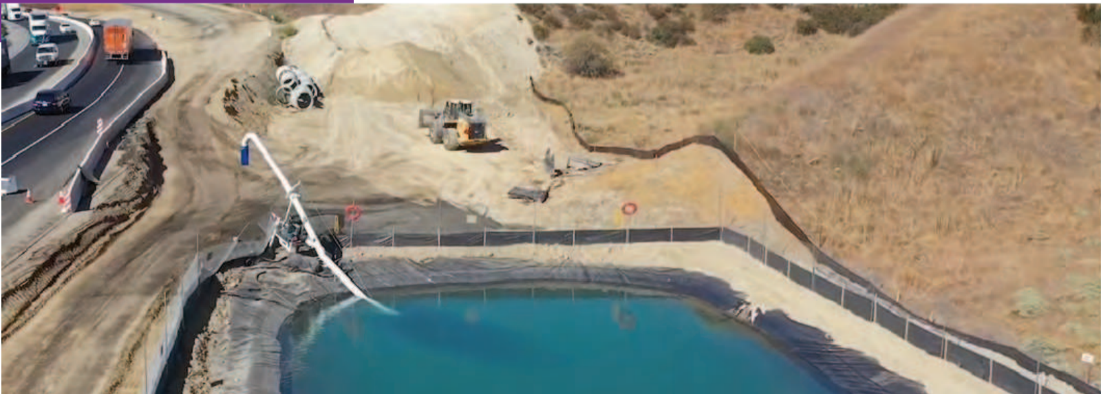
Los equipos han construido dos depósitos de agua temporales para proporcionar un suministro de agua local para el control del polvo.
