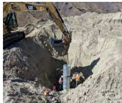
Los equipos continúan colocando 15,000 pies de tubería para 123 sistemas de drenaje.
