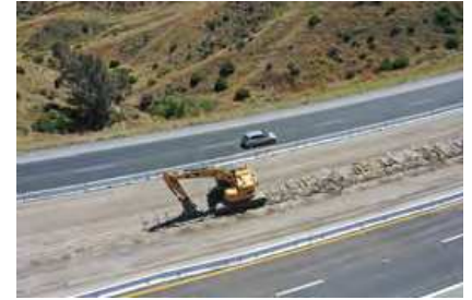
Los equipos están excavando las barreras centrales para aumentar el espacio para carriles adicionales.
