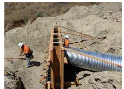
Se están instalando 15,000 pies de tubería para 123 sistemas de drenaje diferentes.
