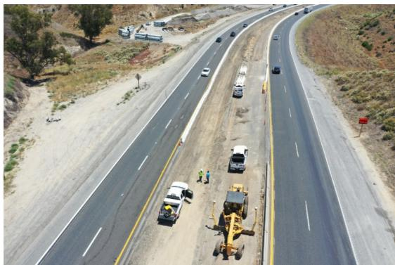
**Los equipos de construcción han comenzado a reparar la barrera del centro en preparación para el próximo cierre de carril de seis meses en dirección oeste.**
