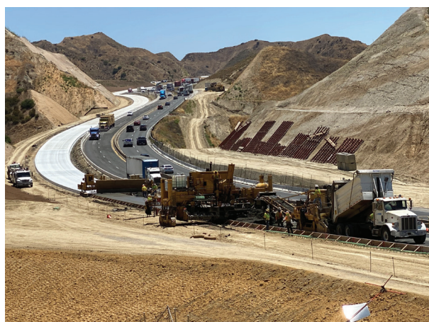
Los equipos están pavimentando los carriles hacia el oeste. Siga leyendo para obtener más información sobre las capas de pavimentación.
